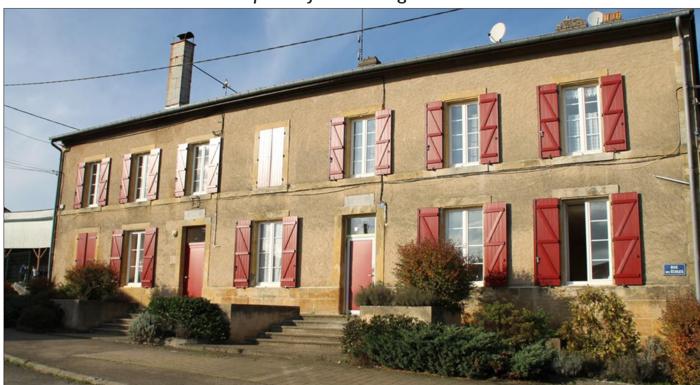
Au rez-de-chaussée, une porte de secours (à gauche) a été créée. Photo RL
