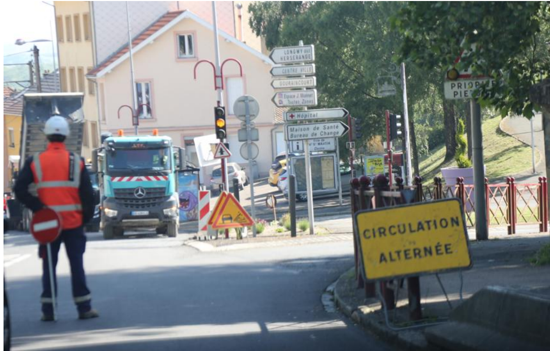
D'importants travaux de réfection de l'enrobé sont actuellement en cours boulevard de Metz à Mont-Saint-Martin. La circulation se fait en alternance jusqu'à mercredi 23 mai. Photo René BYCH
